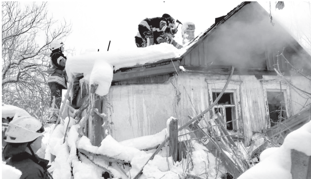
Возгорание жилого дома № 9 по улице Водопьянова
