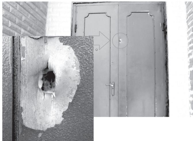
Во входной двери отверстие сквозное
