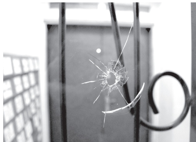
Повреждена и внутренняя дверь
