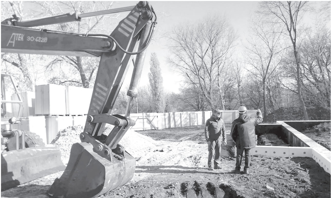
Начало строительства амбулатории в Подлесном в 2018 году
